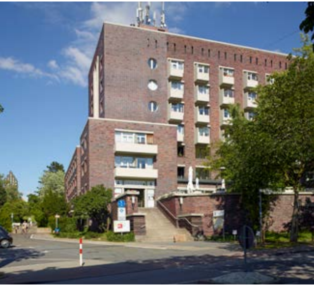
Meisterbau Ledigenwohnheim 1952 Ernst Neufert
